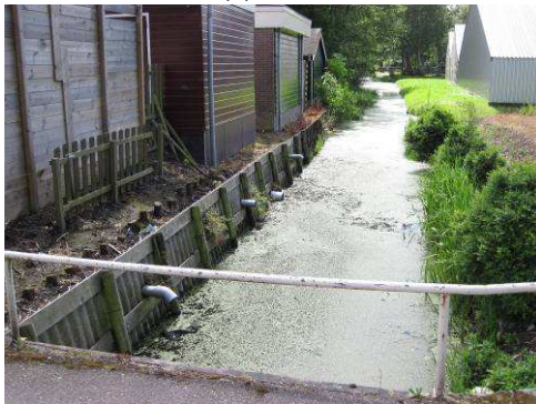
Sloot onder te verbreden brug.
