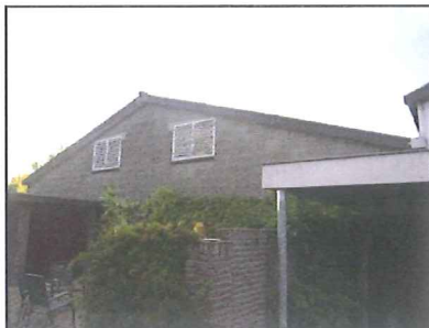
Figuur 3. Bebouwing, zuidzijde onderzoekslocatie.
