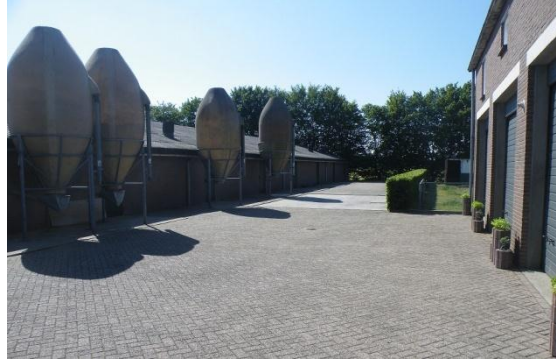
Bedrijfsbebouwing grenzend aan de elzensingel
