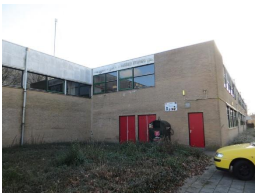
Foto 1 en 2: Schoolgebouw noord en westzijde
