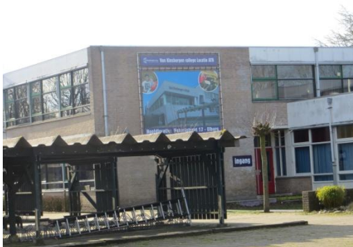
Foto 3 en 4: Schoolgebouw oostzijde
